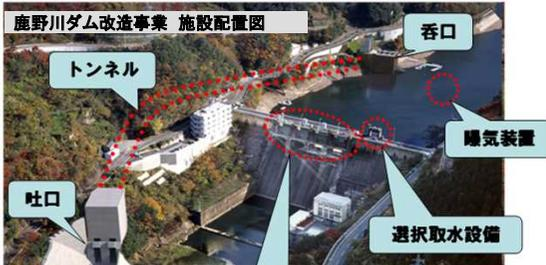
●平成16年の河川整備計画策定を受けて、容量の有効活用を目的とした新設放流設備（トンネル洪水吐）等の改造を実施
