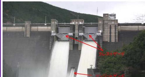
●平成30年7月豪雨による甚大な被害の発生を受けて、平成30年7月豪雨と同規模の洪水を安全に流下させることが出来るよう、放流設備の増設工事を実施中。
