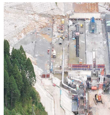
ダム本体(コンクリート打設状況)
