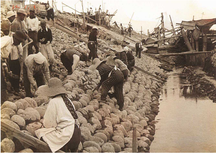
昭和26年堤防整備状況
