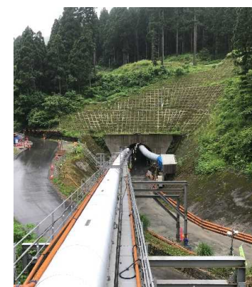
水海川導水トンネル(整備中)
