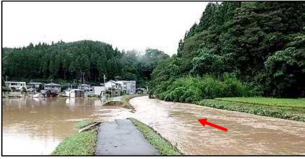
九頭竜川水系 志津川 破堤箇所(福井市大森町)
