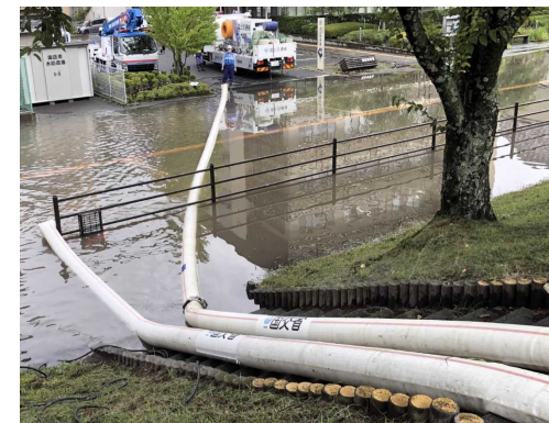
排水ポンプ車による排水状況
