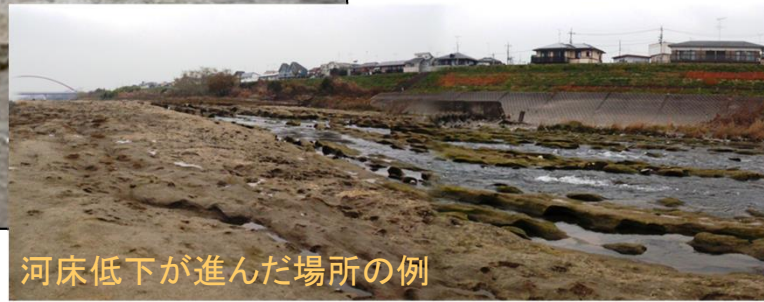
河床に露出している土丹
