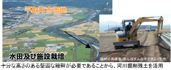
畦畔の再構築（田んぼダムの手引きより引用） 十分な高さのある堅固な畦畔が必要であることから、河川掘削残土を活用
