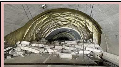
写真① 国道249号大谷トンネル内の崩落
