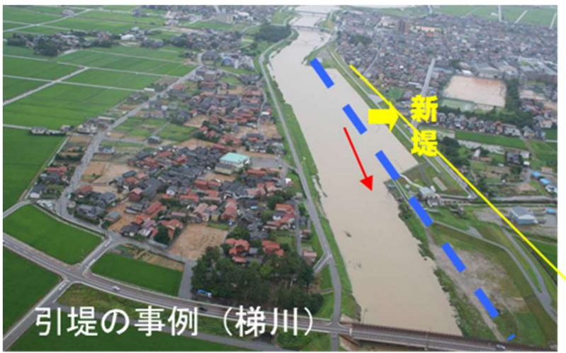
引堤の事例(梯川)
