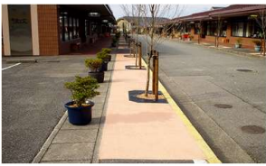
九谷陶芸村 瓦廃材利用保水性舗装
