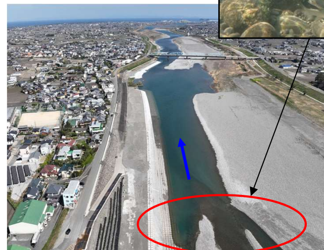
施工後 (No. 3付近)
