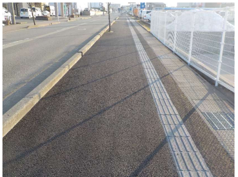
二日市徳用線歩道修繕工事（令和4年度施工） 事業延長 L=150m 歩道幅員 W=3.5m（舗装幅員W=2.3~2.65m） 事業概要 開粒度アスコン A=420㎡
