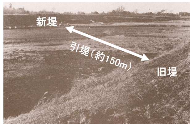
江戸川右岸47.0km付近での引堤状況(昭和28年12月) ※手前は旧堤
