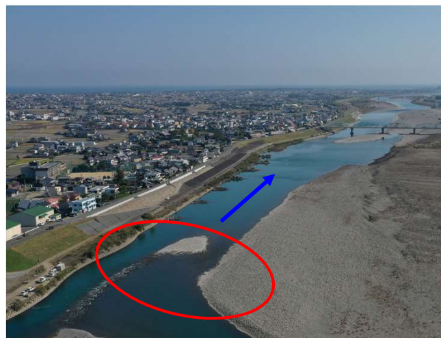
施工前 (No. 3付近)
