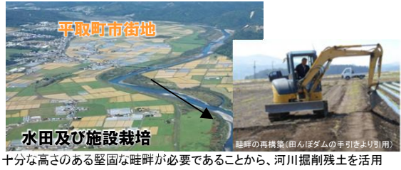
十分な高さのある堅固な畦畔が必要であることから、河川掘削残土を活用
