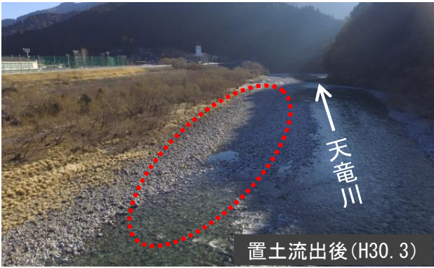
置土流出状況 (65.0k付近、約1万 \text{m}^3 )
