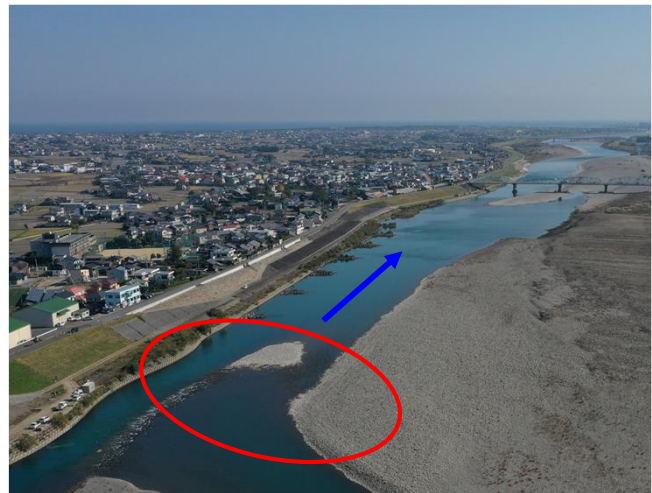
施工前 (No. 3付近)
