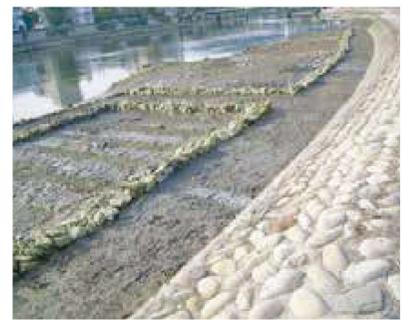
石炭火力発電所から出る石炭灰を粒状に固めた石炭灰造粒材を有機泥の溜まった干潟に埋め込む。
