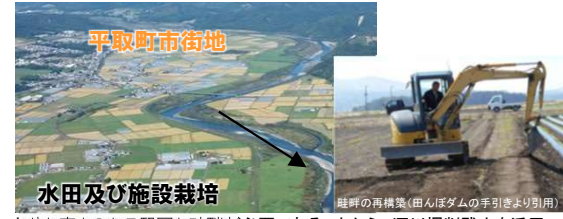
十分な高さのある堅固な畦畔が必要であることから、河川掘削残土を活用
