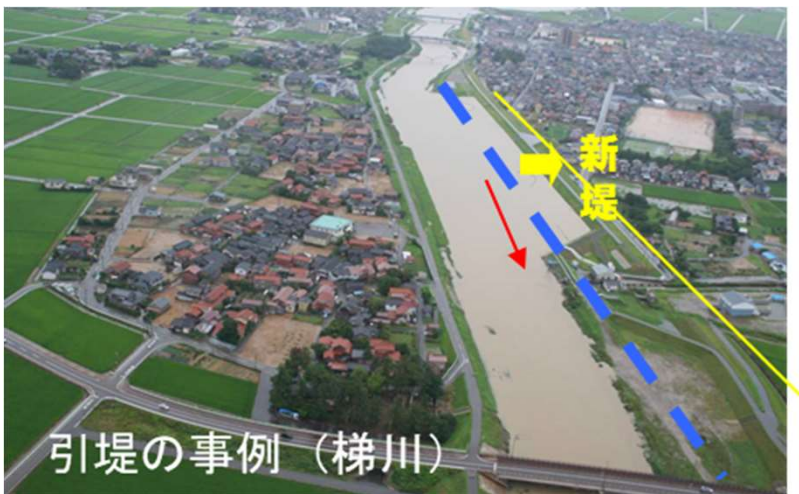
引堤の事例(梯川)
