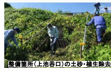
整備箇所(上池呑口)の土砂・植生除去
