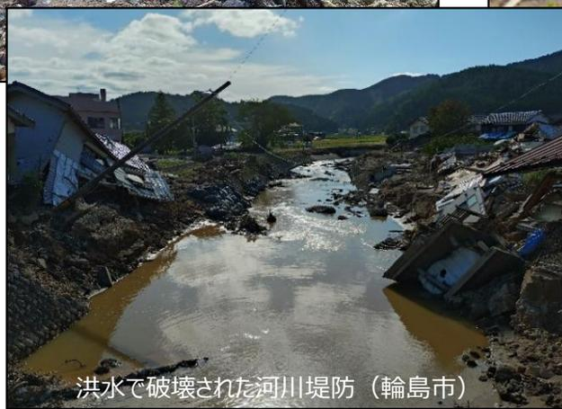
洪水で破壊された河川堤防（輪島市）
