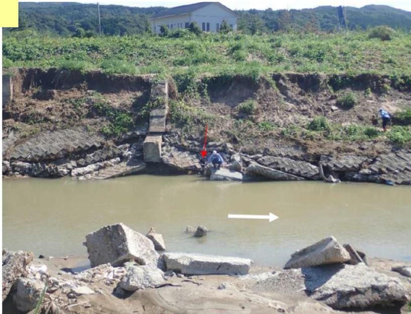
地震で隆起(3.5m)した場所で護岸が損傷
