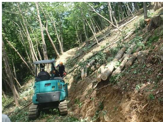
整備中の様子
