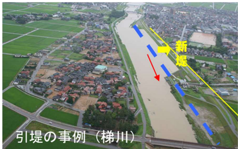
引堤の事例(梯川)
