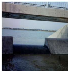
加古大池（稲美町） 事前水位低下のための 洪水吐一部切り下げ
