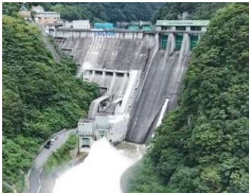
五十里ダム環境放流(約100m³/s)
