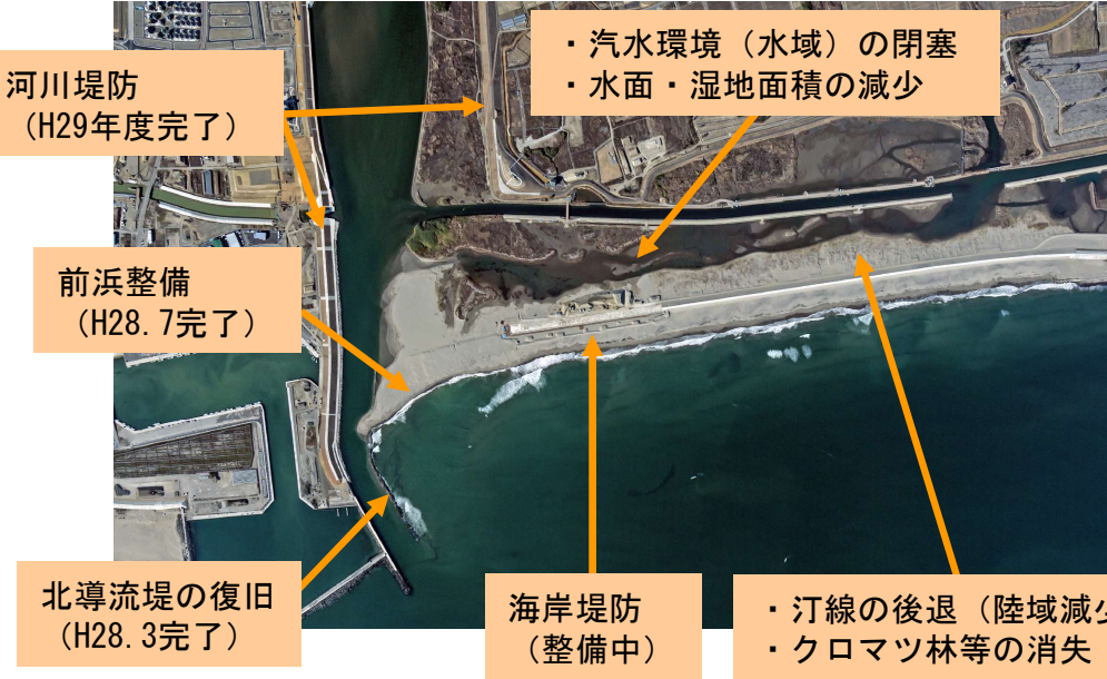
平成29年12月 7日（河川堤防復旧完了）
