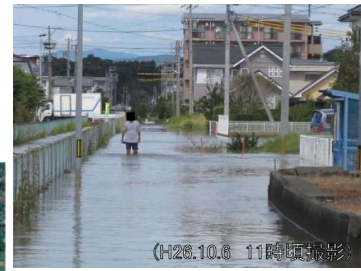
浸水被害状況(平成26年10月)
