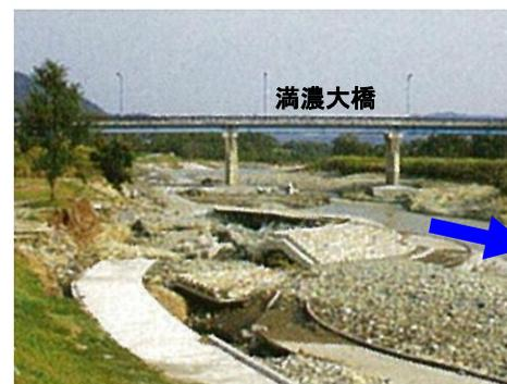
護岸崩壊、橋脚基礎露出
