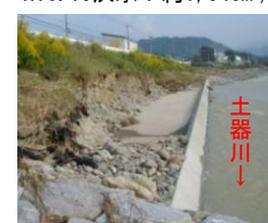
低水河岸付近の洪水流速が増大し、河岸侵食・洗掘被害が多発
