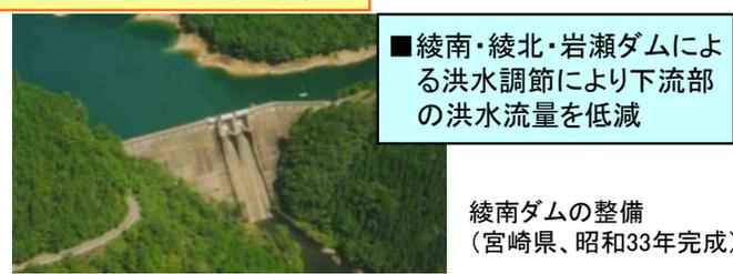
■綾南・綾北・岩瀬ダムによる洪水調節により下流部の洪水流量を低減
