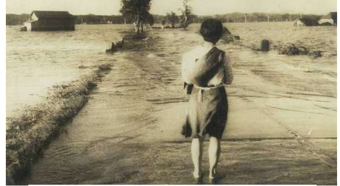
旧三本木（大崎市）奥州街道沿いの橋梁が水没
