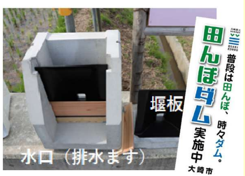
田んぼダムの実施状況（堰板配布）
