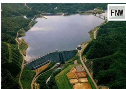
③ 南川ダム
