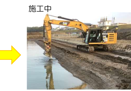
干潟環境を還元する掘削
