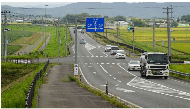
二線堤（バイパス区間：既成）
