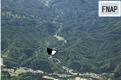
① 鳴瀬川ダム（建設中）
