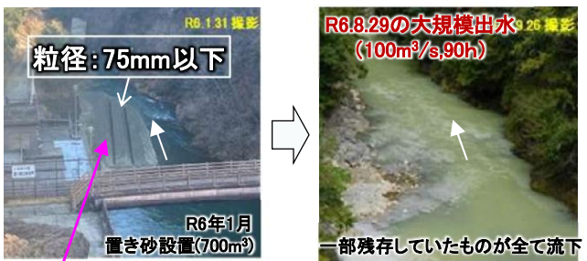
置き砂の設置・流出の状況(令和6年)
