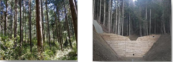
間伐による森林整備(山梨県) 土石流対策の治山施設設置(山梨県)
