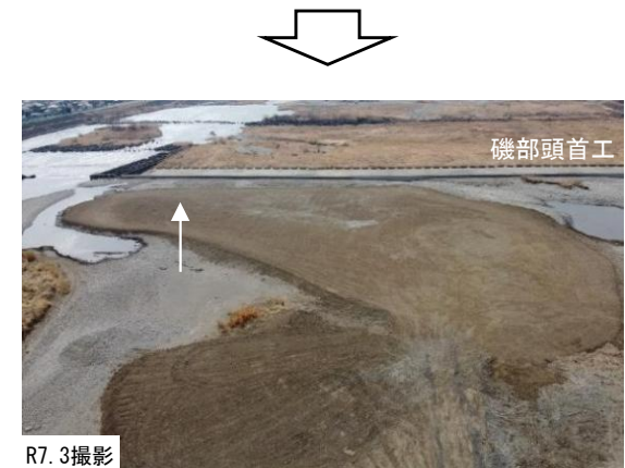
河道掘削及び樹林化対策(磯部頭首工上流)
