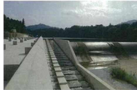
頭首工右岸の放流工に魚道を整備
