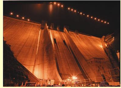
ダム下流面から見た夜景(H6)
