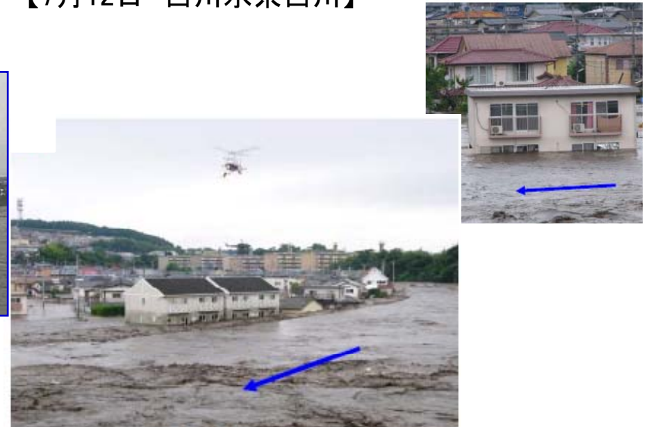
熊本市北区龍田陣内(熊本県管理区間)
