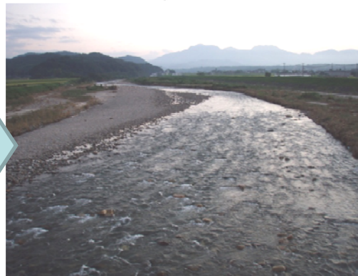
出水後の状況
