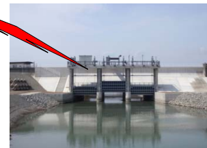
水門・樋門等
