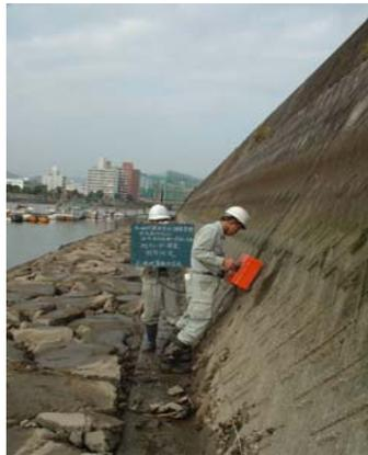
携帯型探査器による護岸部の探査
