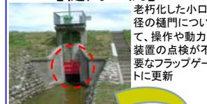
老朽化した小口径の樋門について、操作や動力装置の点検が不要なフラップゲートに更新
