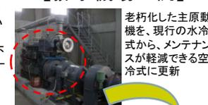
老朽化した主原動機を、現行の水冷式から、メンテナンスが軽減できる空冷式に更新
