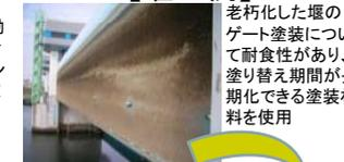
老朽化した堰のゲート塗装について耐食性があり、塗り替え期間が長期化できる塗装材料を使用
