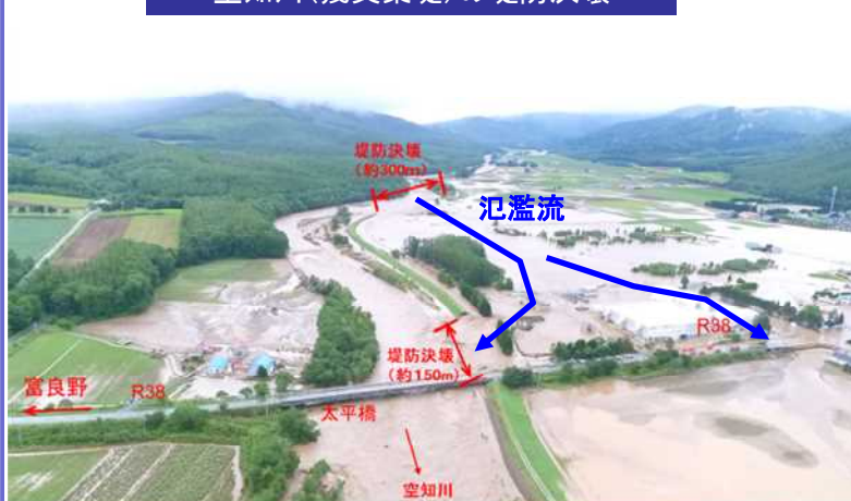
①堤防決壊の状況
