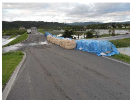
【岩手県久慈市】久慈川水系長内川の事例:大型土嚢の設置
