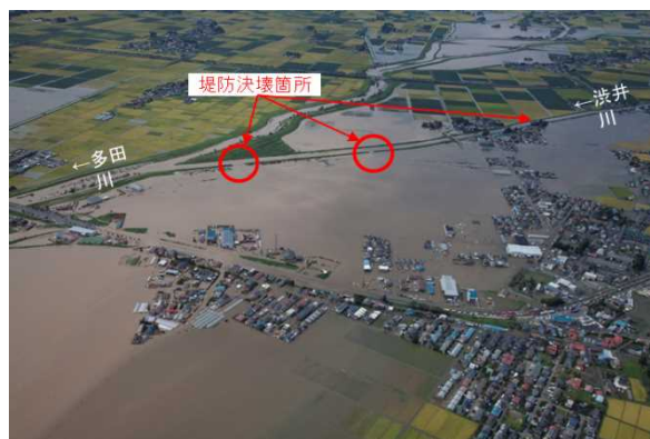
浸水状況(大崎市)
