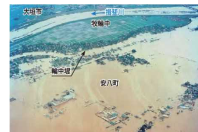
輪中堤による浸水被害の軽減
