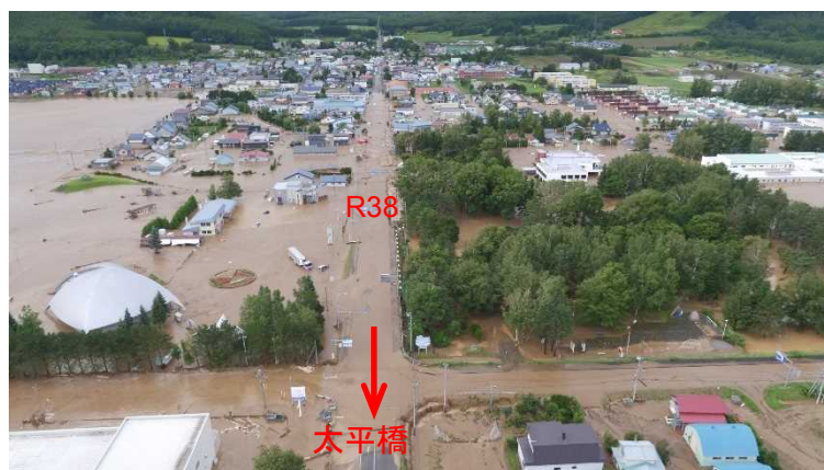
②浸水状況
