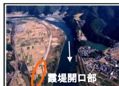
差木野地区の霞堤
