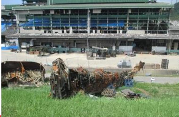
爆発した工場と高梁川の堤防に飛散した設備
