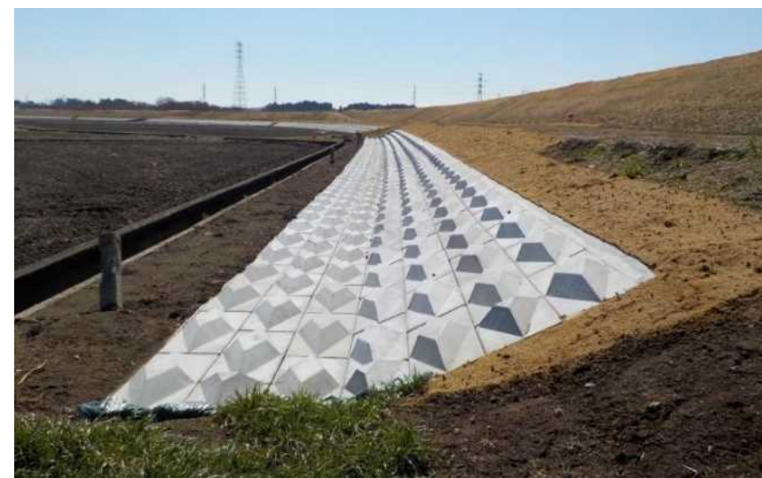
法尻補強の事例(久慈川)
