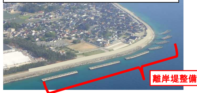
離岸堤の整備による高潮対策事例
