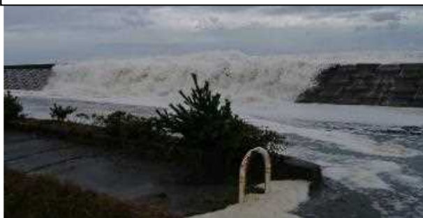
高潮による堤防越波状況
