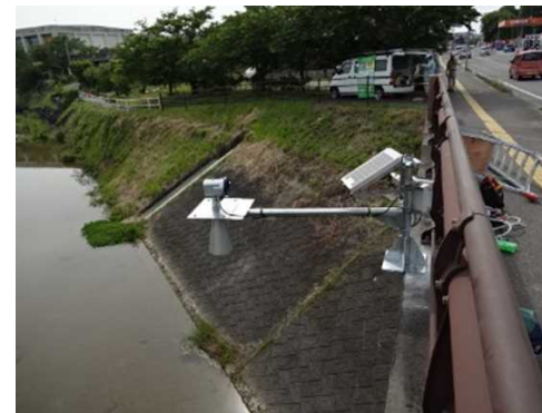
危機管理型水位計の設置
