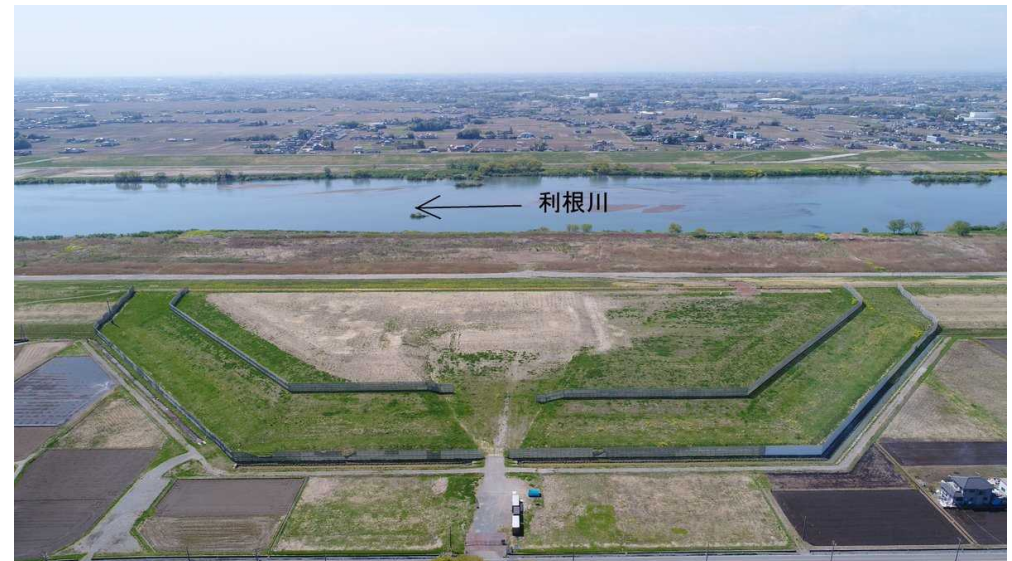
栄地区広域避難地(埼玉県加須市)
