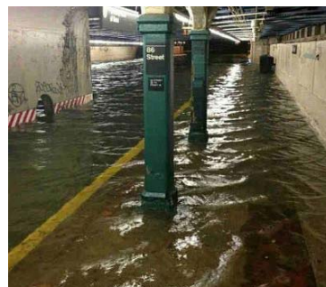
平成24年10月 ニューヨーク市内の地下鉄駅の浸水状況
