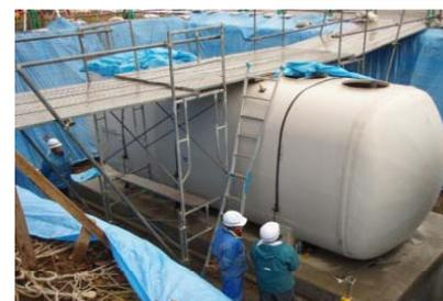
工場製作型極小規模処理施設
