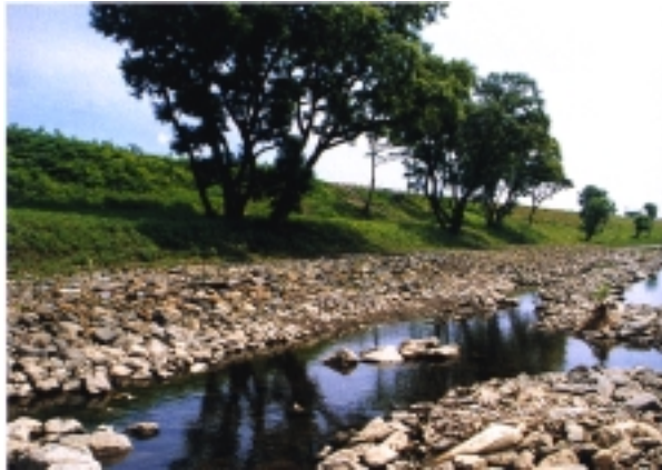
多自然型川づくり(朴瀬護岸) ほのきせ
