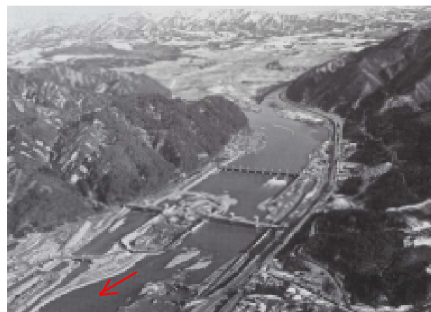
水害後、拡幅改築が行われた荒川頭首工
