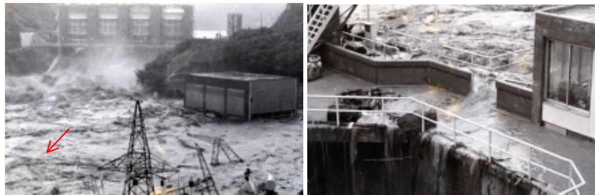
岩船ダムの被災状況
