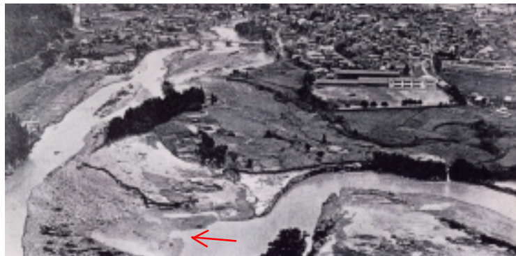
荒川上流部 大量の土砂堆積が生じた支川横川の被害(小国町)
