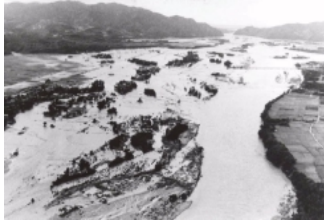
羽越水害の被害状況(関川村)
