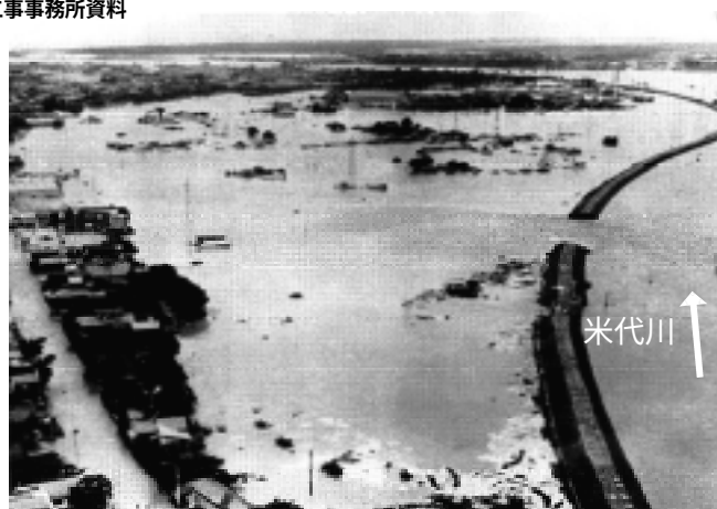
昭和47年7月洪水による被害状況
