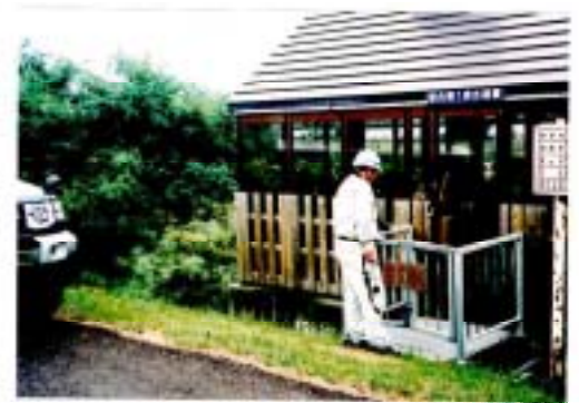
【河川巡視状況（排水樋管の点検）】
