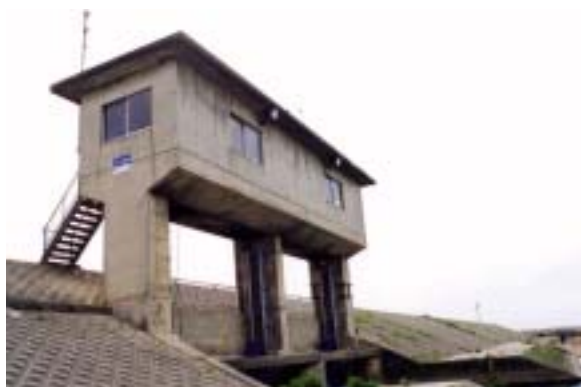
乙大日川樋門（荒川町海老江）
