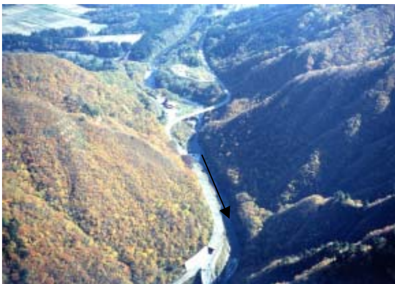
中流部 赤芝ダム周辺 (山間狭窄部)
