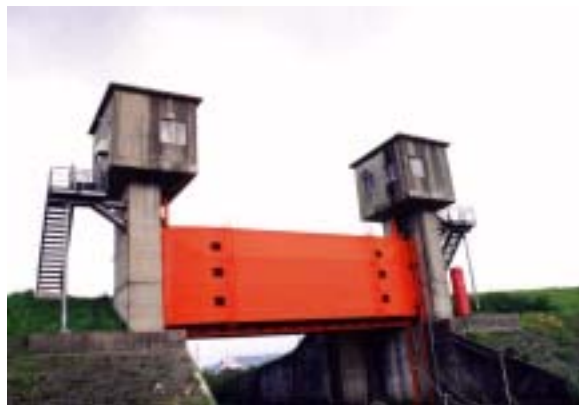
赤谷川制水門（関川村打上）
