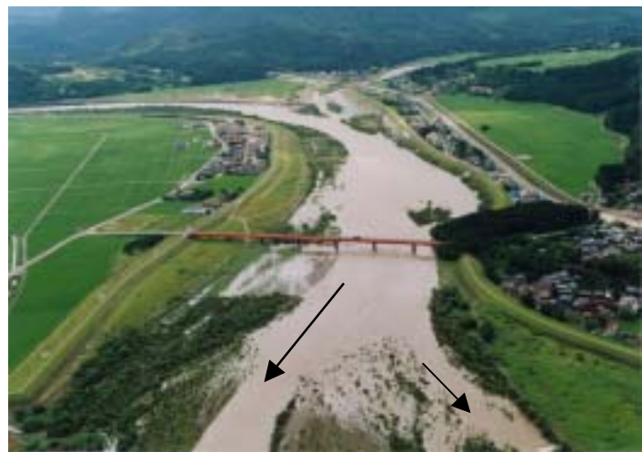
荒川 16.5 km 温泉橋付近
