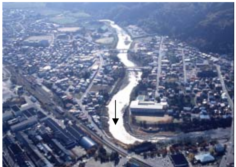
上流部 小国町付近 (平地部)
