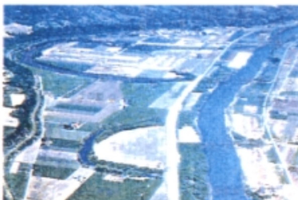
昭和9年に着工された智恵文第1新水路 (写真手前)
