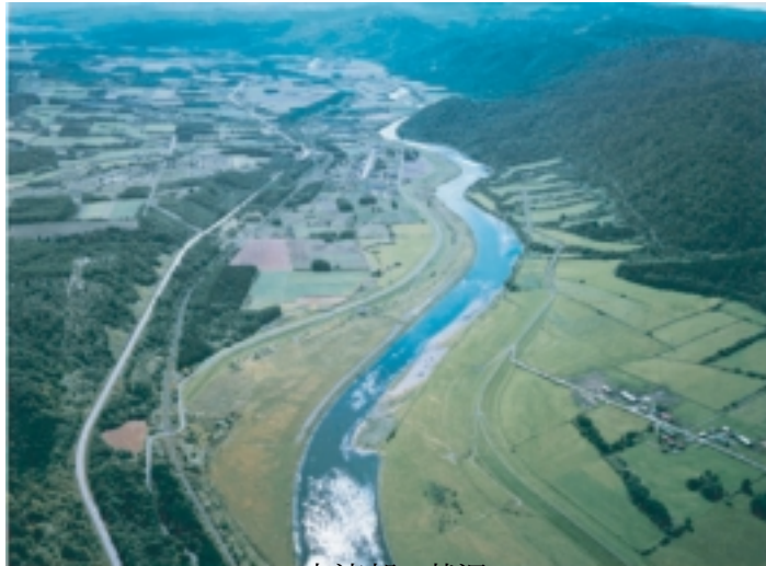
中流部の状況
