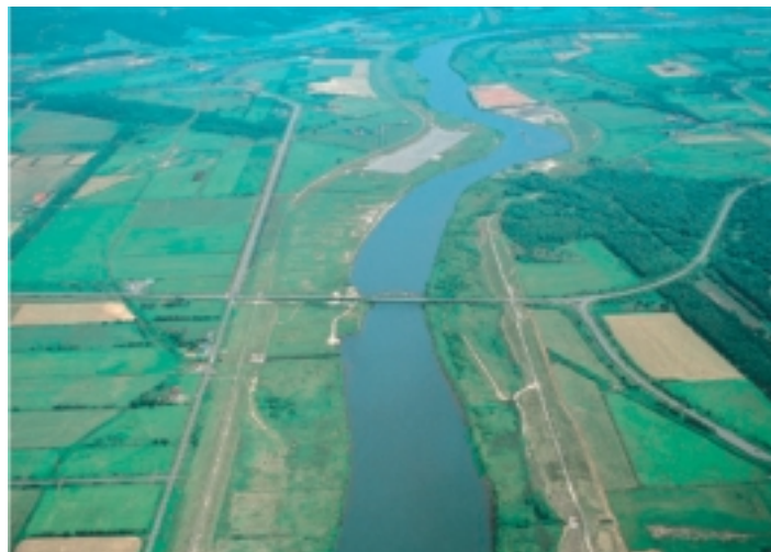
下流部の状況
