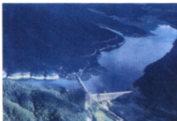
昭和 46 年に完成した岩尾内ダム
