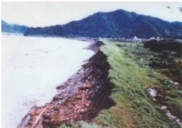
昭和57年洪水（破堤寸前の堤防浸食）
