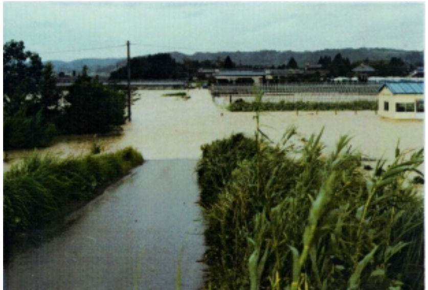
下小松地区 (8/000右岸付近) 浸水状況
