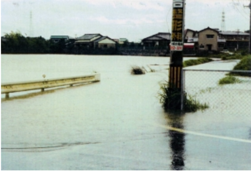
下小松地区 (8/000右岸付近) 浸水状況
