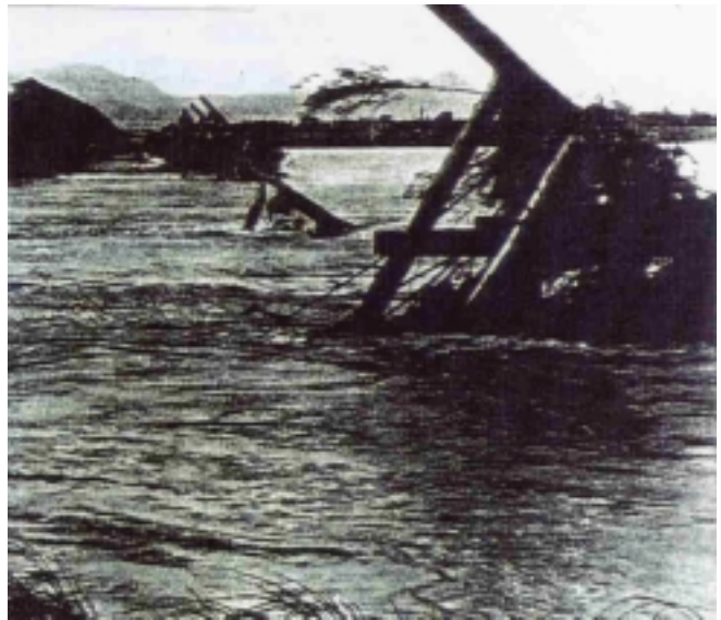
流出した高松橋 (宮崎市)
