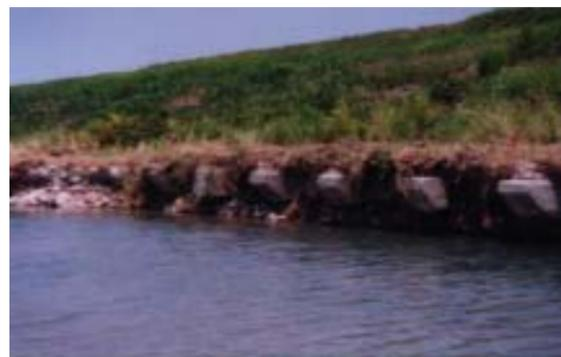
出水による護岸の基礎の浮き上がり状況 (H9.7.17 洪水、 $Q=1,880\text{m}^3/\text{s}$ )
