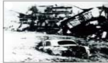
壊滅的な被害を受けた厚狭温泉橋
