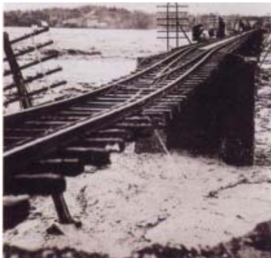
昭和 9 年 7 月洪水(国鉄[現JR]手取橋梁)
