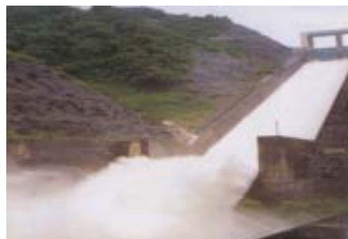
洪水調節する洪水吐ゲート(手取川ダム)
