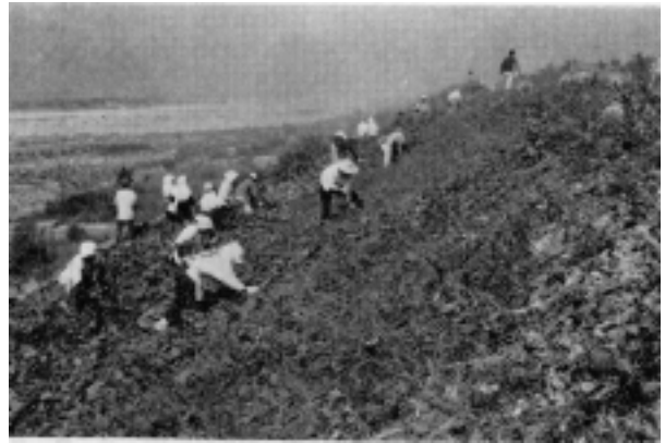
堤防の除草作業状況
