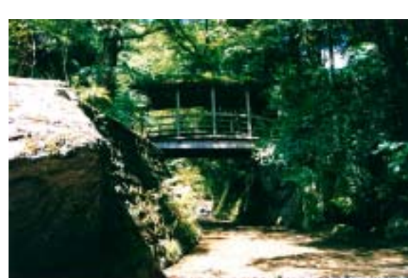
6.御幸の橋（屋根付き橋）
