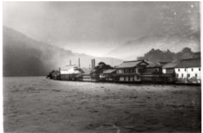
昭和 18 年 7 月洪水 肱川橋上流
