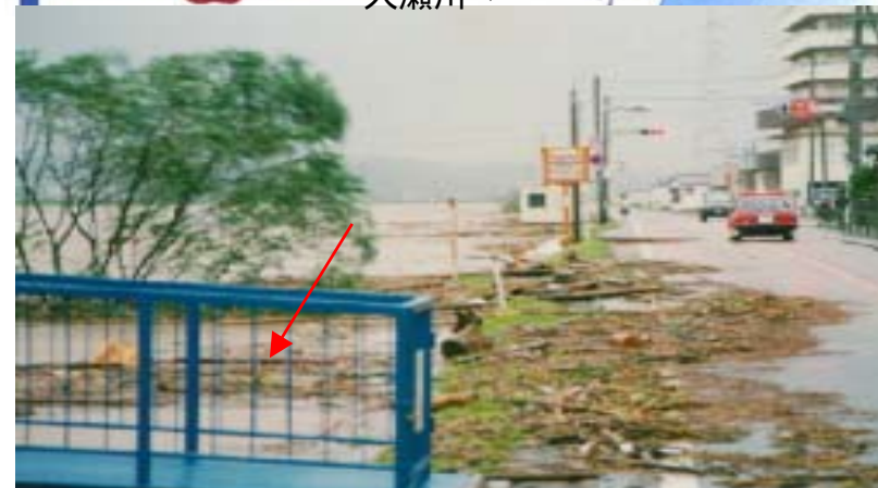
H.W.L.を越え、更に波浪により道路に流木が打ち上げられる等危険な状態の五ヶ瀬川(平成5年8月洪水:延岡市)
