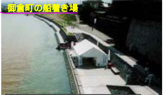
平成の大改修事業の一環として御倉町の川岸に復元された石積み護岸の船着き場
