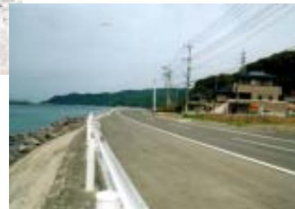
灘地区宅地嵩上事業完成 (平成12年)
