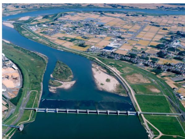
代表的な河川構造物 阿武隈川大堰
