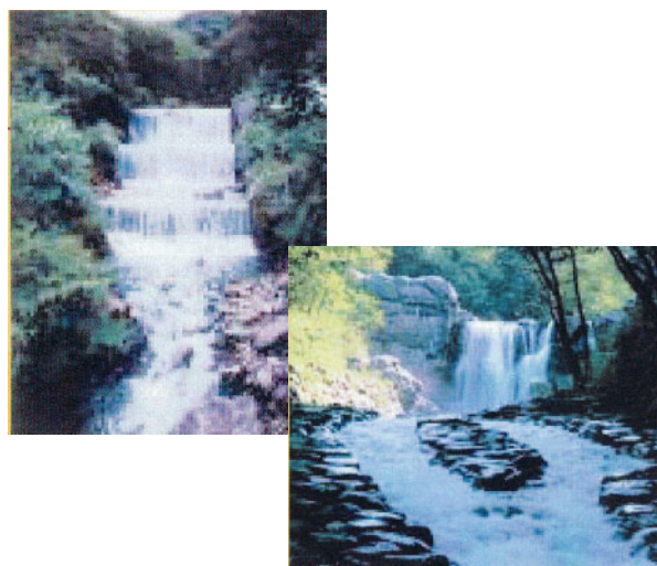
東鴉川第 1 堰堤 (写真左) と東鴉川第 2 堰堤 (写真右)
