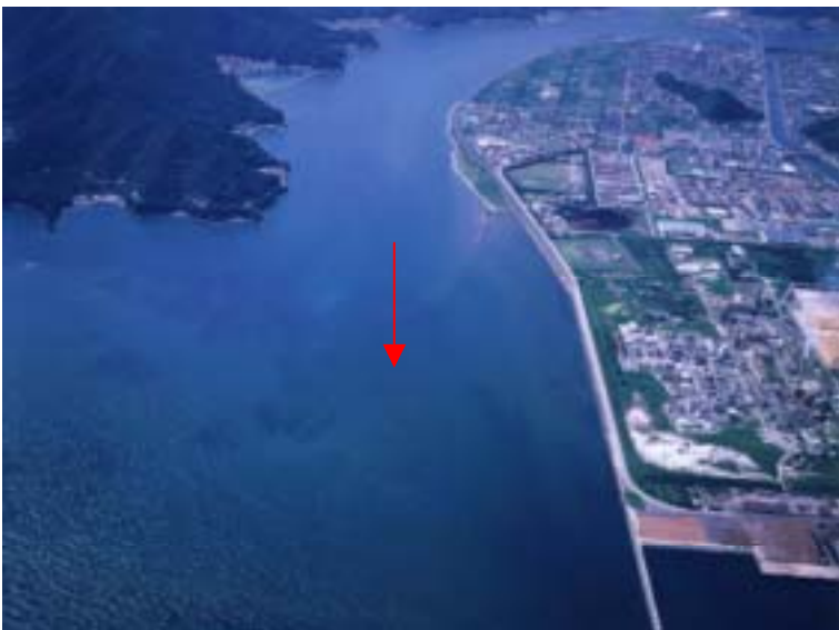
下流部 (河口付近)
