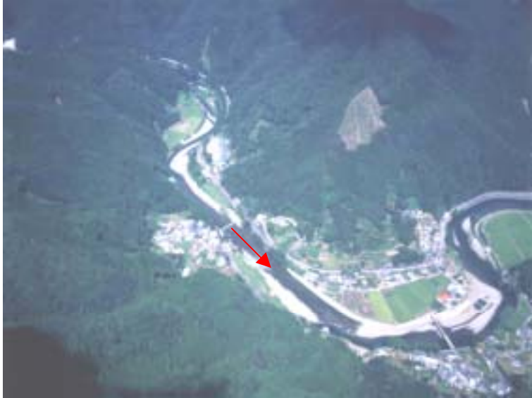
上流部 (直轄上流端付近)
