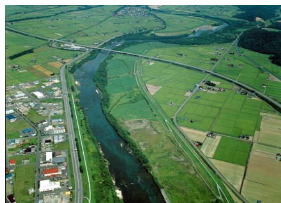
空知大橋 (KP2.75) 付近
