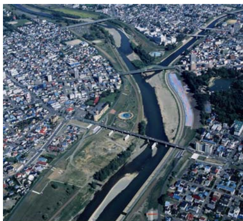
旭橋(KP157.20)付近
