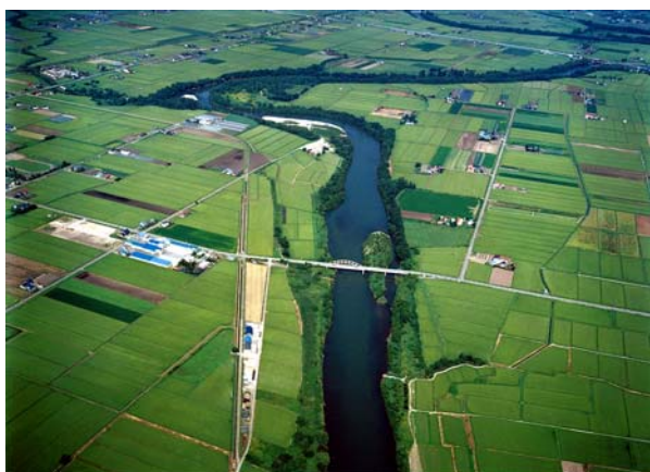
納内橋(KP130.00)付近
