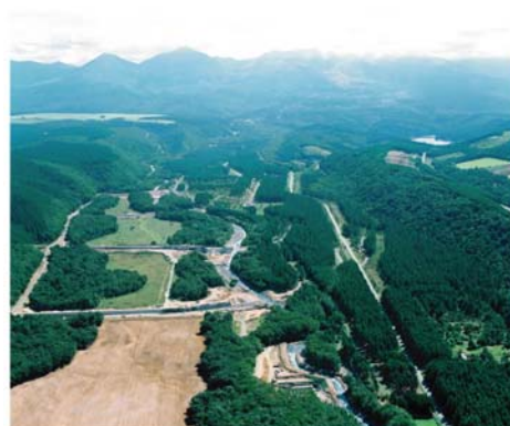
KP45.00 より上流付近
