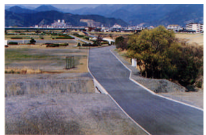
③緊急用河川敷道路
