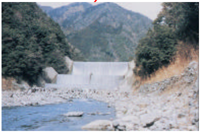
大河内砂防えん堤（S26.3 完成）
