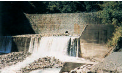
金山砂防えん堤（S31.1 完成）
