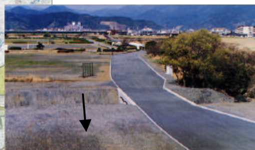
緊急用河川敷道路 (安倍川6.5km付近左岸)
