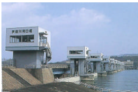
芦田川河口堰（昭和 56 年 6 月完成）
