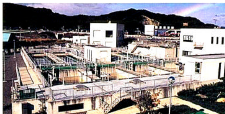
高屋川河川浄化施設
