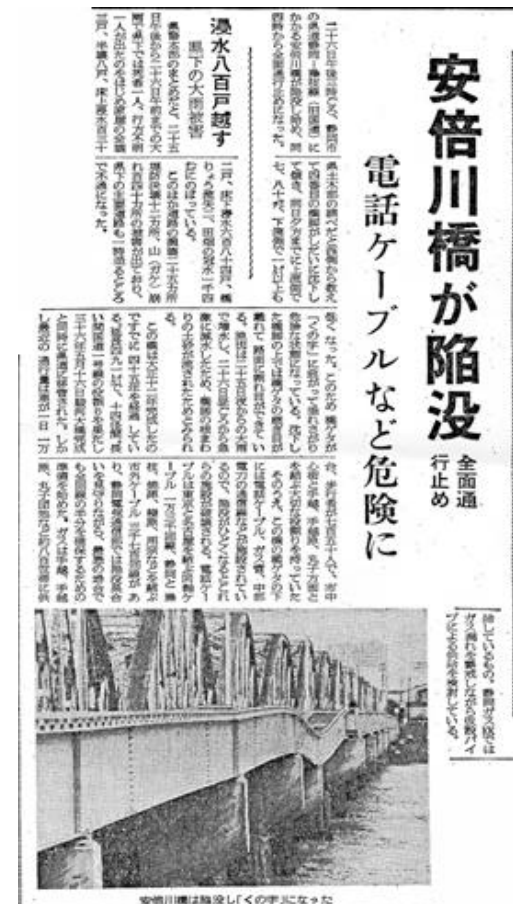
昭和44年 6月洪水 安倍川橋 (4.0k付近) 陥没の新聞記事 (昭和44年 6月27日静岡新聞)
