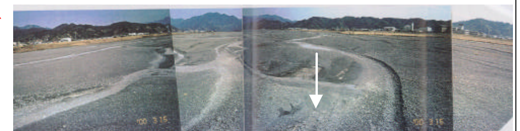
平成12年3月撮影 安倍川大橋上流 (左岸8.0k付近)
