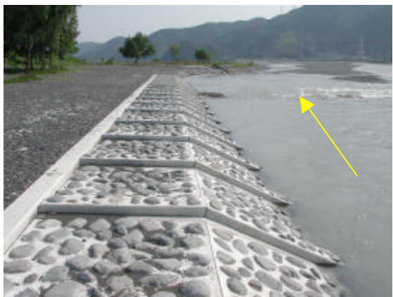
低水護岸（左岸17.0k付近）
