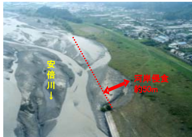
平成12年9月洪水 (左岸11.75k付近)
