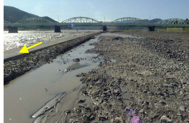
平成14年7月洪水 (左岸4.0k付近)
