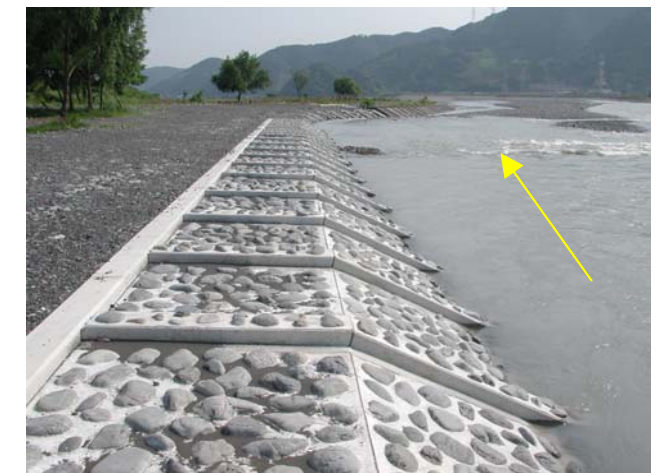
低水護岸 (左岸17.0k付近)
