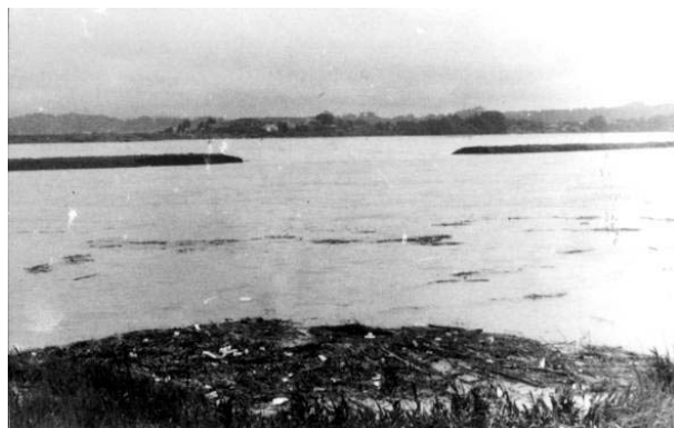
堤防破堤箇所(宮内)を右岸より望む
