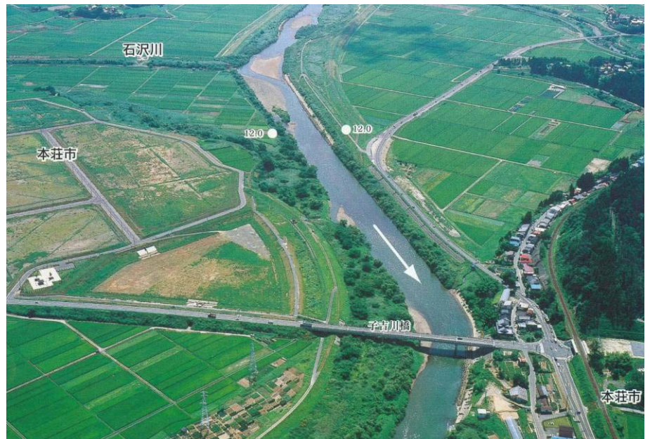
【石沢川合流付近の河道の状況】
