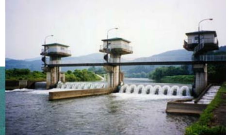
【河口から 24.5k にある滝沢頭首工】
