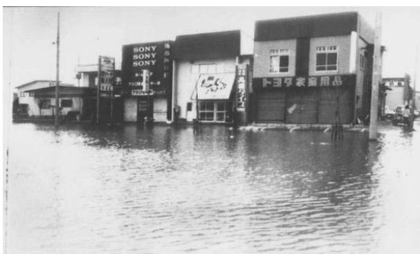
大沢川の氾濫による本荘市市街地の浸水
