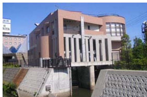
【大沢川排水機場】
