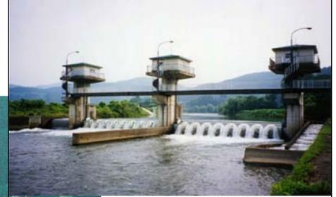
かんがい面積 602.5ha、最大取水量  $2.993\text{m}^3/\text{s}$ 。子吉川水系で最大の農業用水の取水施設である。
