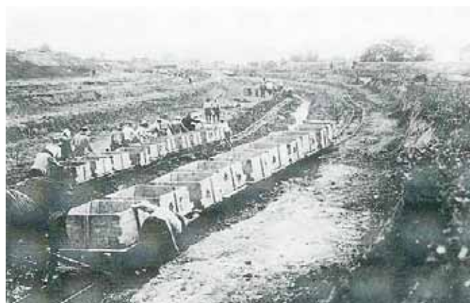
軟弱地盤のため軌道が歪み土運搬は困難を極めた
