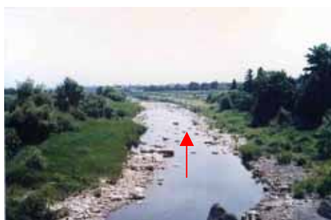
上岩木橋より下流 (出典：青森河川国道事務所資料)
