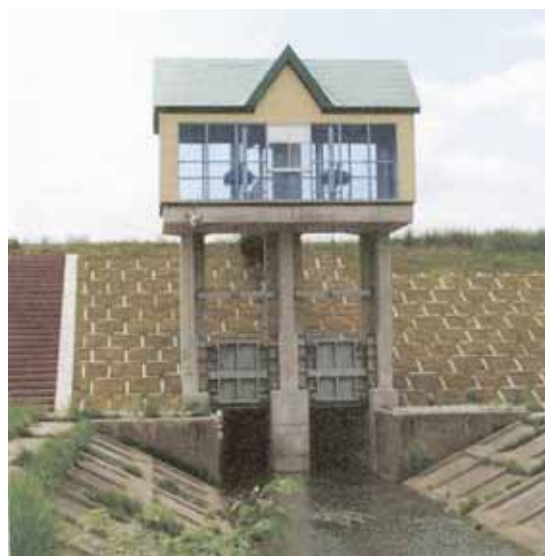
平川第五排水樋管
