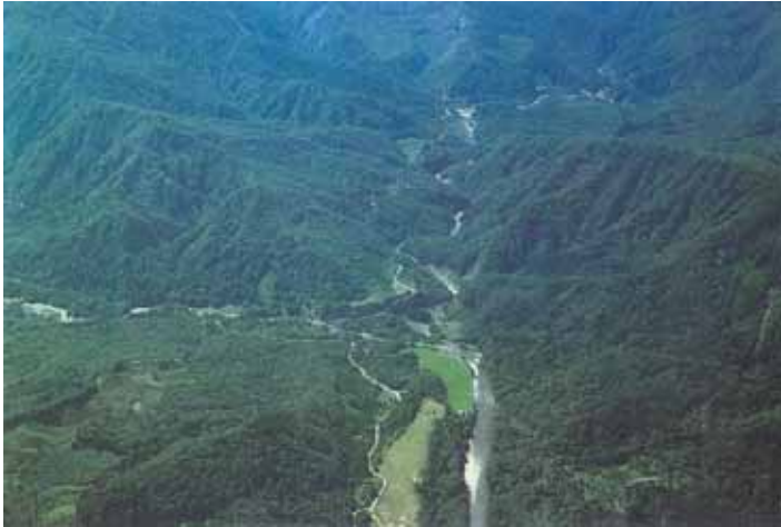
【上流部(山間部)の河道の状況】
